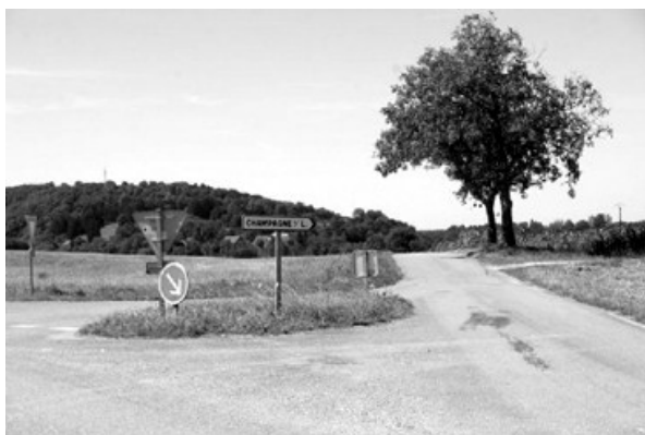
Carrefour avant modification
